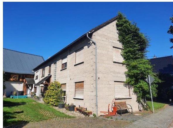
Abbildung 89: Wohnhaus mit Sanierungsbedarf in der Isselbacher Straße
