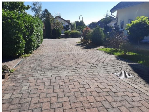
Abbildung 232: Bodenschwelle in der Straße Im Neuroth
