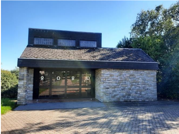
Abbildung 187: Trauerhalle mit gepflastertem Vorplatz
