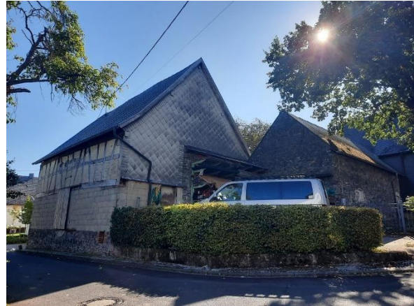
Abbildung 91: Nebengebäude mit Sanierungsbedarf in der Mittelstraße
