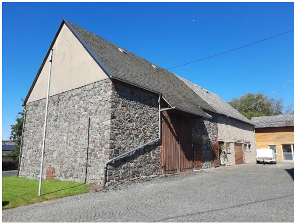
Abbildung 54: Nebengebäude mit sichtbarem Naturstein
