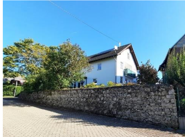
Abbildung 152: Natursteinmauer in der Gelbachstraße
