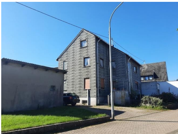
Abbildung 88: Wohnhaus mit Sanierungsbedarf in der Sespenroder Straße
