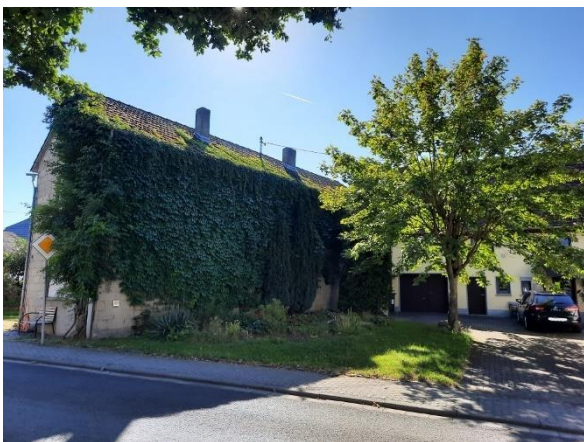
Abbildung 149: Begrüntes Wohngebäude und Hofbaum in der Isselbacher Straße / K 165
