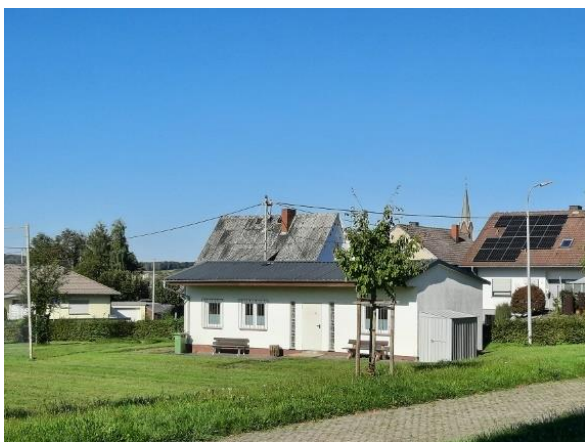
Abbildung 179: Sportlerheim mit Blick in Richtung Nordosten
