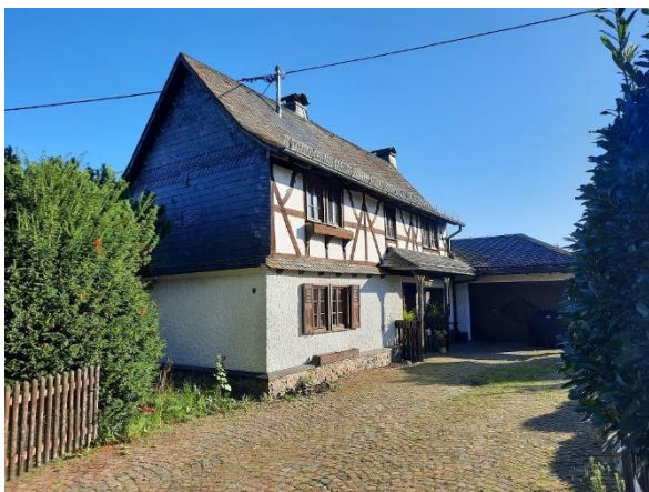
Abbildung 60: Fassadenverkleidung aus Naturschiefer in der Straße Am Sportplatz
