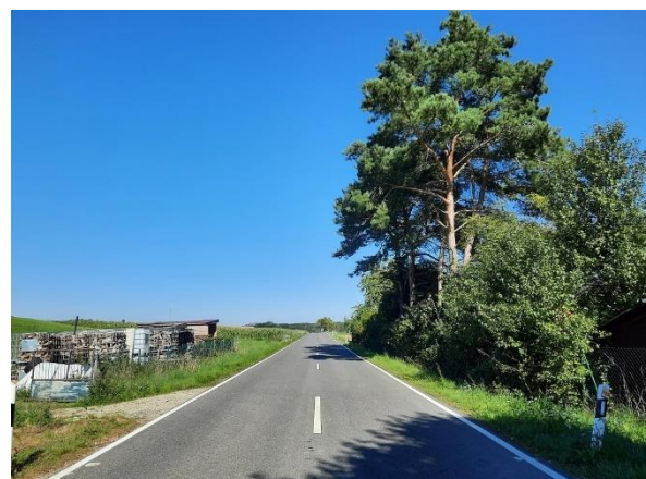
Abbildung 209: Ortsausgang an der K 165 / Schulstraße in Richtung Nentershausen mit Blick in Richtung Nordosten
