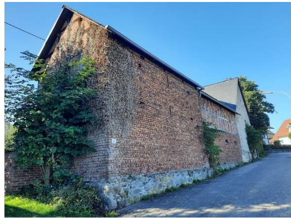
Abbildung 55: Nebengebäude mit sichtbarem Fachwerk, Naturstein und Ziegelstein
