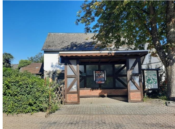
Abbildung 201: Wartehäuschen in der Sespenroder Straße an der Ecke zur Kirchstraße
