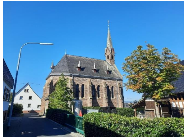
Abbildung 190: Kirche mit Blick in Richtung Westen
