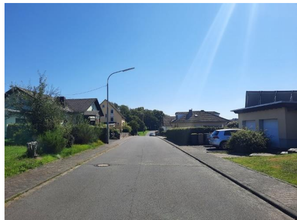
Abbildung 228: Breiter und gerader Straßenverlauf in der Eichheider Straße
